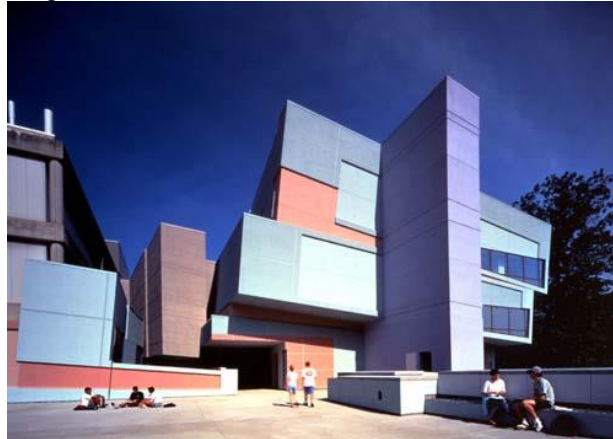
Imagem 65 – Foto do edifício do Aronoff Center
